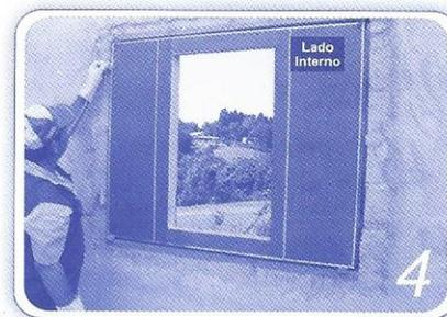
5 - Com a peça nivelada e prumada, inicie a fixação com massa. Deixe secar e retire os calços. Feche os buracos onde estavam os calços e com massa faça os acabamentos na parede.
